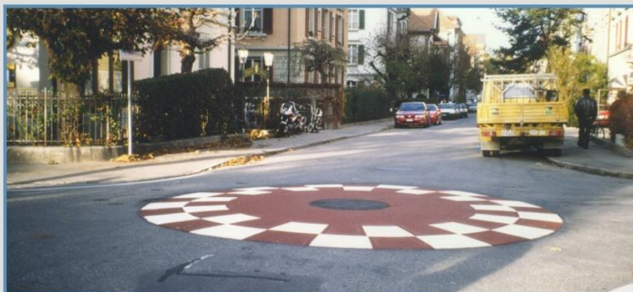
Intersezione con calotta di bitume
